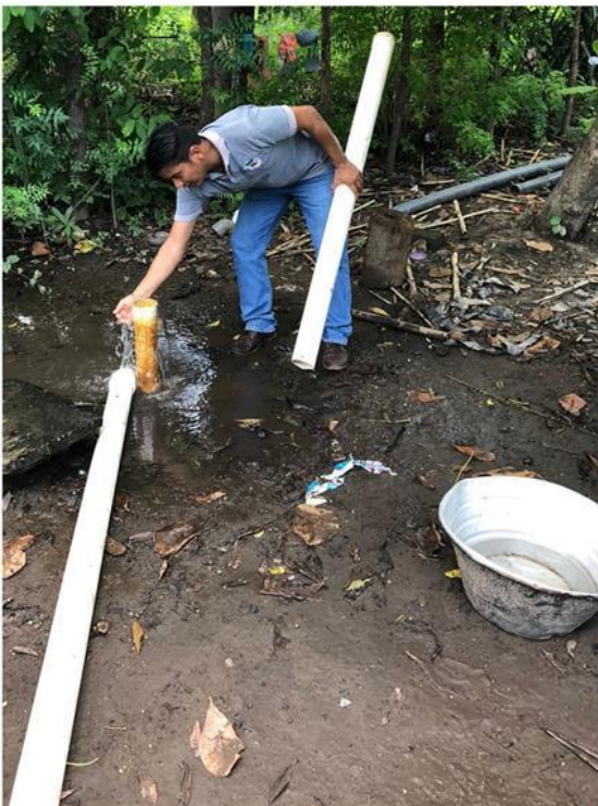
Ruperto, el técnico del proyecto, muestra como se usa una "puntera", que sirve para regar los cultivos y usar en los hogares en época de sequía
